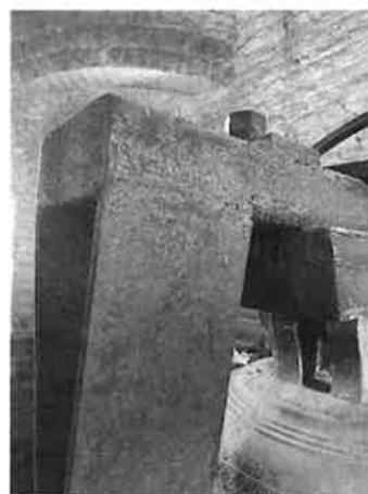
Foto 2 en 3: Roestvorming op de luidbruggen van de twee klokken.
