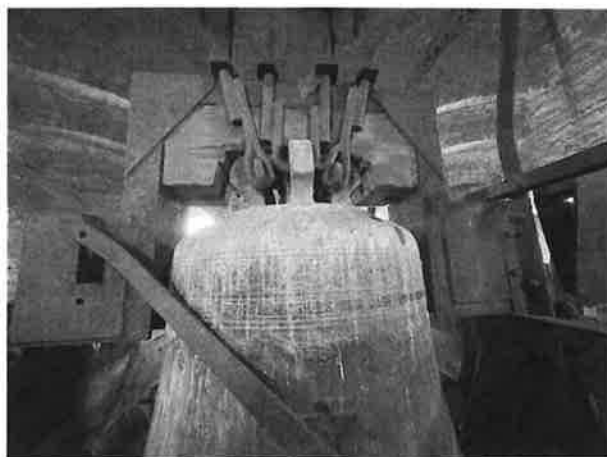
Foto 2 en 3: Roestvorming op de luidbruggen van de twee klokken.
